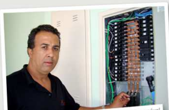
O eletricitista, Handerson Matos e a equipe responsável pela restauração do Prédio Sede da Escola de Saúde Pública do Estado de Minas Gerais (ESP-MG)
